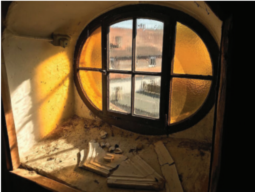
Vier ovale Fenster befinden sich auf der Süd- und Nordseite des Kirchenschiffes. Auf der Südseite oben die Jahrzahl 1733 (Aufstockung).
