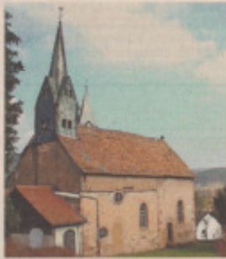
Die frühere Pfarrkirche St. Laurentius in der Ortsmitte von Sommerau steht leer und verfällt allmählich. Archiv-Foto: Martin Bachmann.
