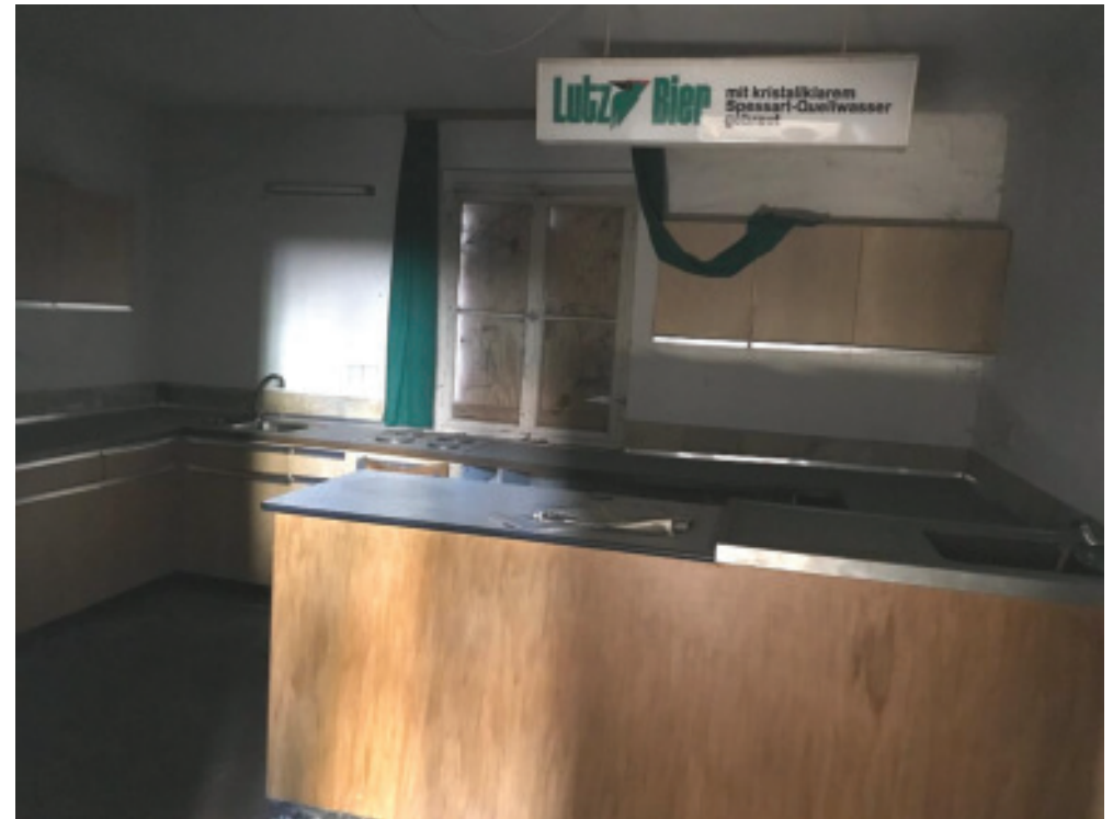
Auf der Nordseite wurden Räumlichkeiten geschaffen für eine Schanktheke und Küchenzeile. Ein Ofen für die Saalheizung wurde hier installiert. Auch Toilettenanlagen wurden eingerichtet.
